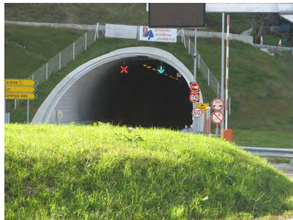
Tunel južne obvoznice
