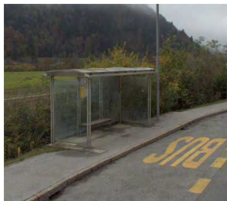
Primer avtobusne nadstrešnice – oseba s slabšo vidno zaznavo lahko spregleda stekleno steno (potrebna kontrastna oznaka)
